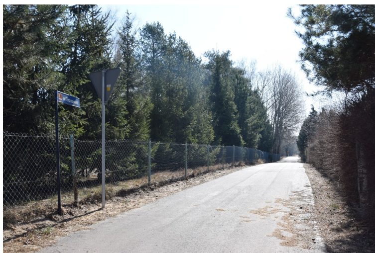
Przebudowany odcinek drogi gminnej Dąb Mały - Dąb Polski.
