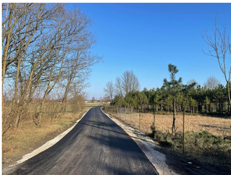
Przebudowany odcinek drogi gminnej w miejscowości Przerytka.
