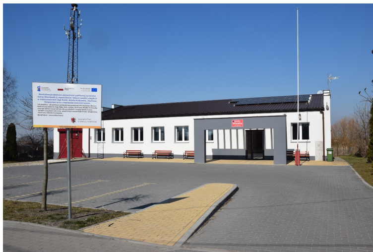
Mikroinstalacje fotowoltaiczne na dachu świetlicy w Świętosławiu.
