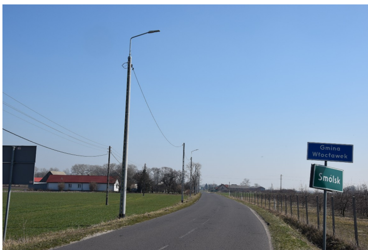
Oświetlenie drogowe w miejscowości Smólsk.
