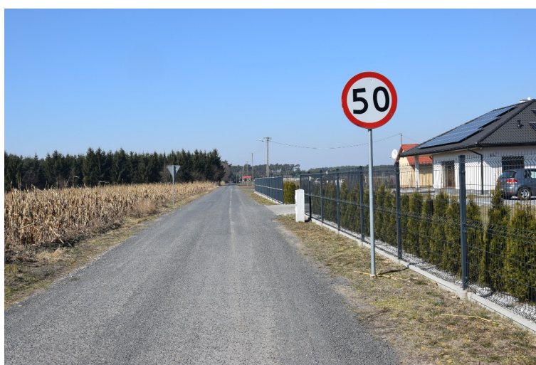
Przebudowany odcinek drogi gminnej w miejscowości Łagiewniki.
