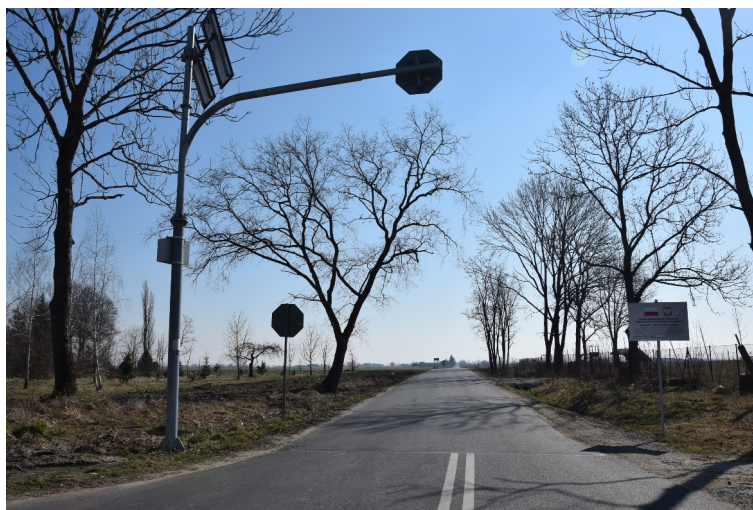
Przebudowany odcinek drogi gminnej w miejscowości Humlin.
