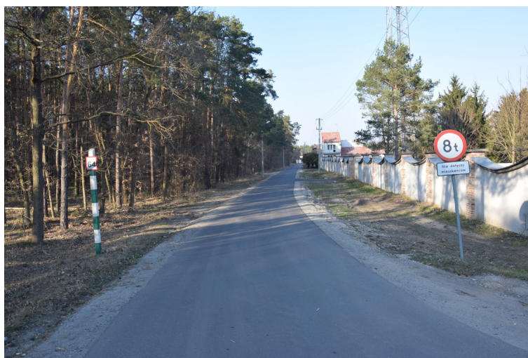
Przebudowany odcinek drogi gminnej w miejscowości Potok.
