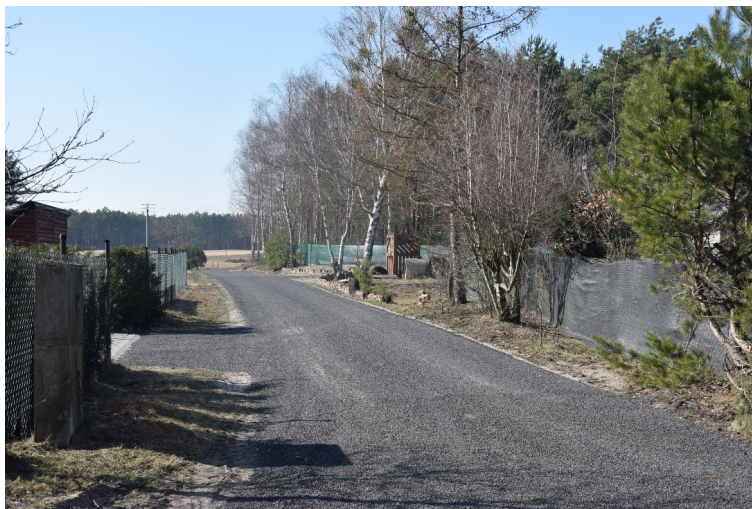
Przebudowany odcinek drogi gminnej w miejscowości Telążna Leśna.
