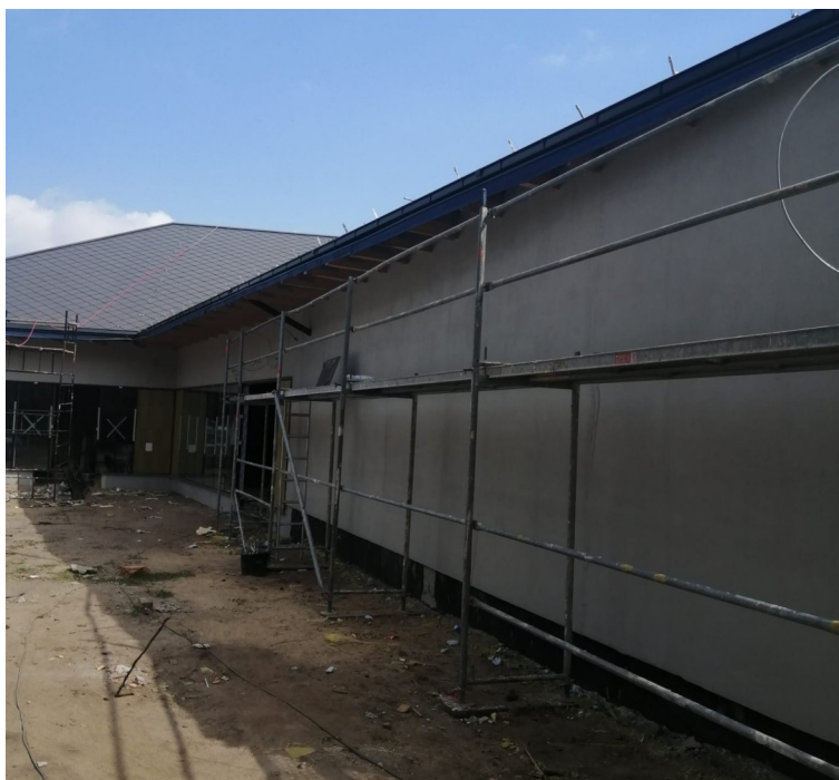
Centrum Integracji Wiejskiej w miejscowości Smólnik.
