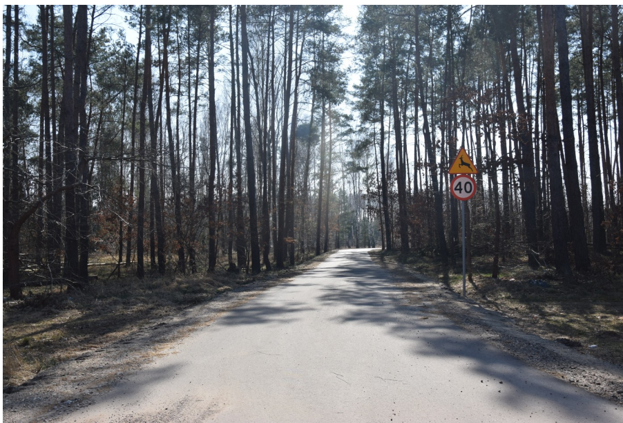
Przebudowany odcinek drogi gminnej Wistka Szlachecka – Stasin.
