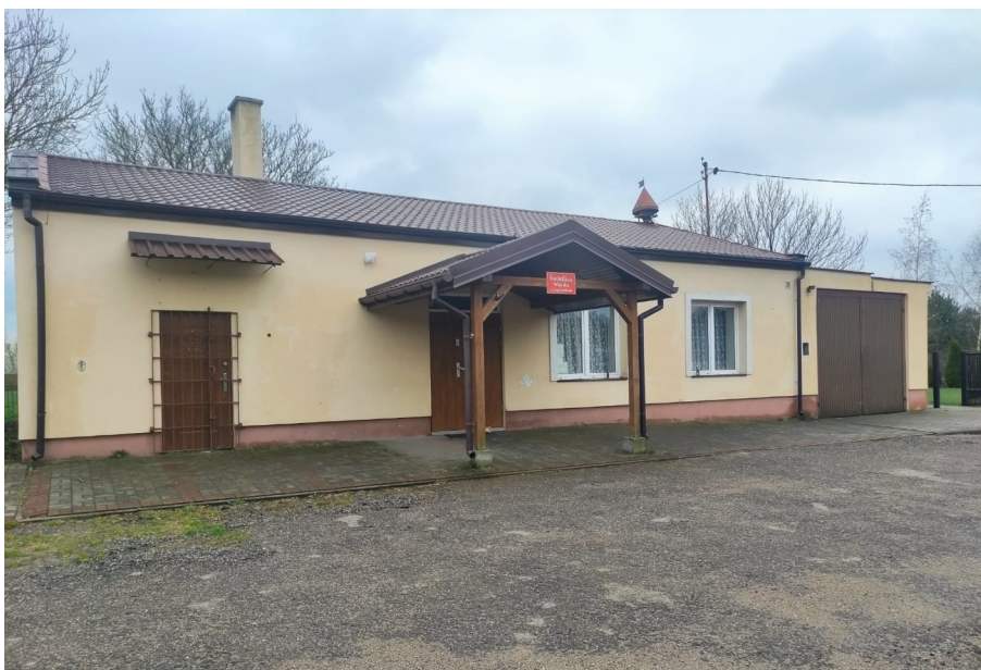
Świetlica w Łagiewnikach.
