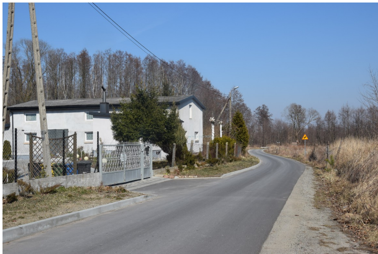
Przebudowany odcinek drogi gminnej w miejscowości Mostki.
