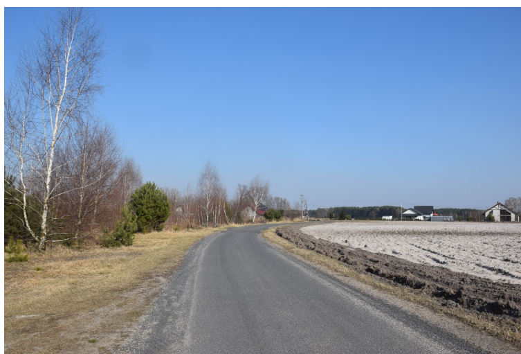
Przebudowany odcinek drogi gminnej w miejscowości Józefowo.
