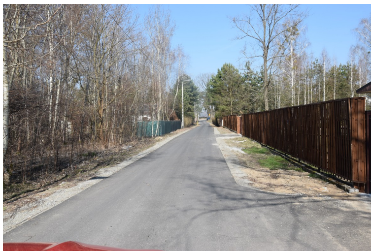
Przebudowany odcinek drogi gminnej w miejscowości Dobiegniewo.
