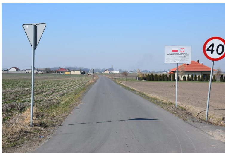
Przebudowany odcinek drogi gminnej w miejscowości Ludwinowo.
