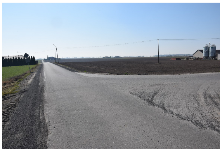
Przebudowany odcinek drogi gminnej w miejscowości Kruszynek.
