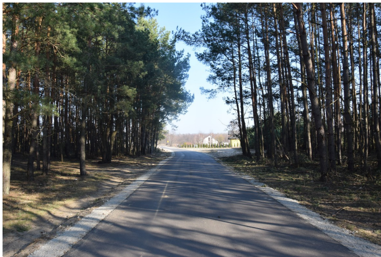
Przebudowany odcinek drogi gminnej w miejscowości Modzerowo.
