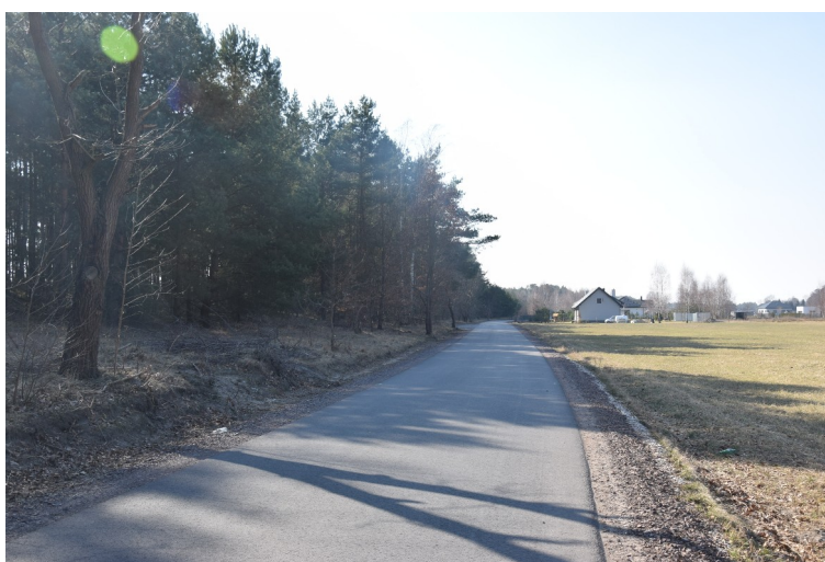
Przebudowany odcinek drogi gminnej w miejscowości Ładne.
