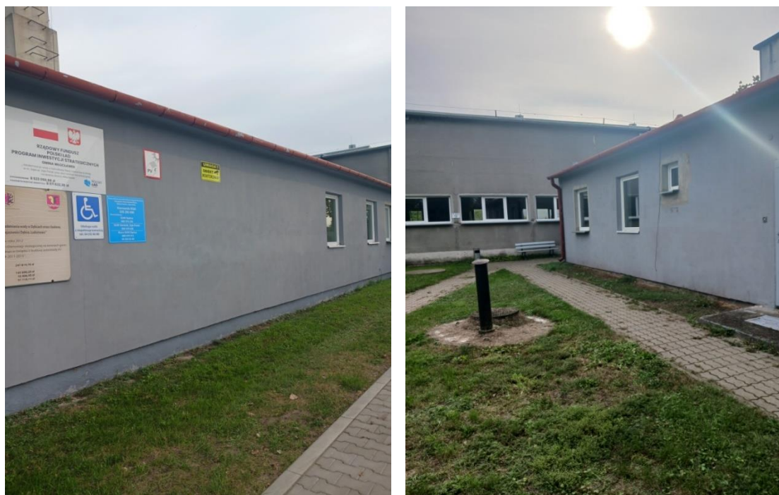
Rysunek 25. SUW Dębice – przed termomodernizacją
