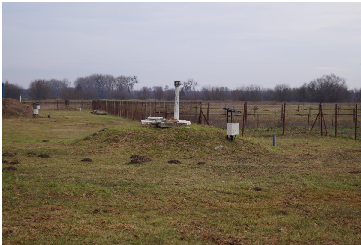
Rys. 25 Otwór Nr 3 Ujęcie Dębice
