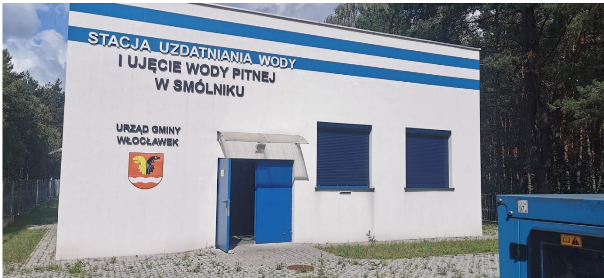
Rys. 13 SUW Smólnik budynek Źródło: Opracowanie własne
