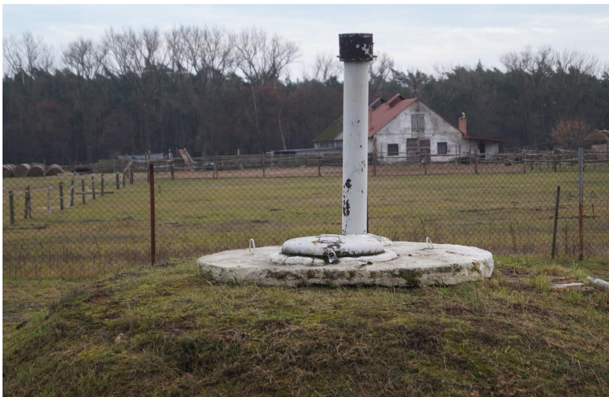
Rys. 22 Otwór Nr 1 Ujęcie Dębice
