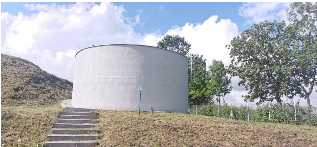
Rys. 31 SUW w Dębicach
