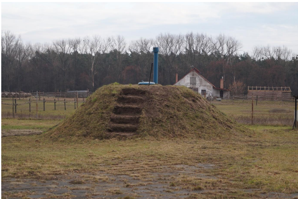
Rys. 23 Otwór Nr 2 Ujęcie Dębice
