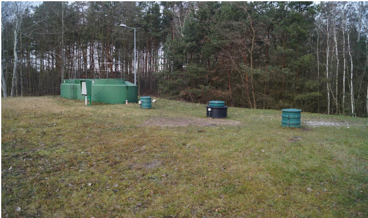
Rys. 32 Oczyszczalnia ścieków w Modzerowie Źródło: opracowanie własne
