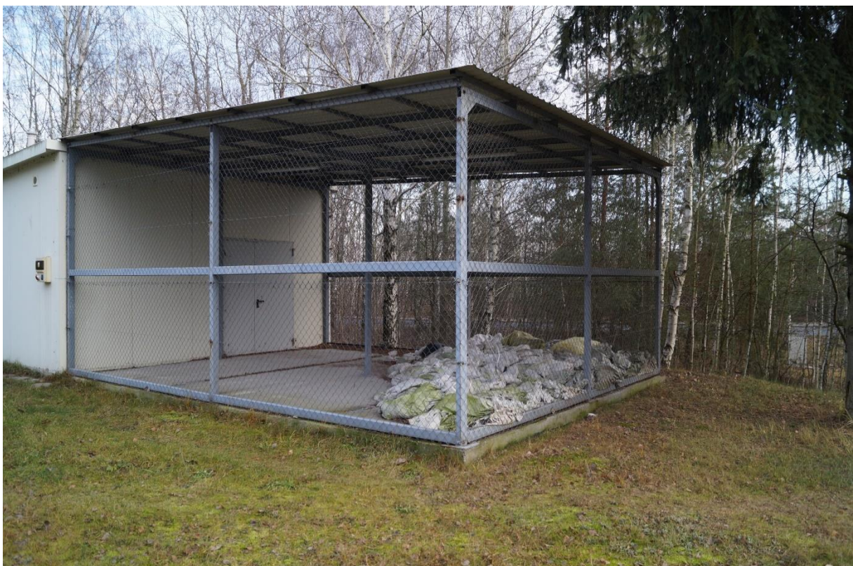
Rys. 34 Składowisko zdezynfekowanych odpadów Źródło: Opracowanie własne
