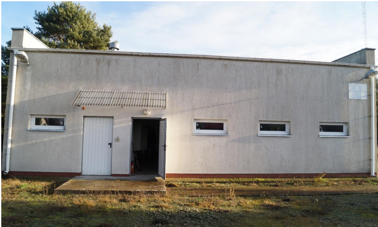
Rys. 18 SUW w miejscowości Dąb Polski front budynku
