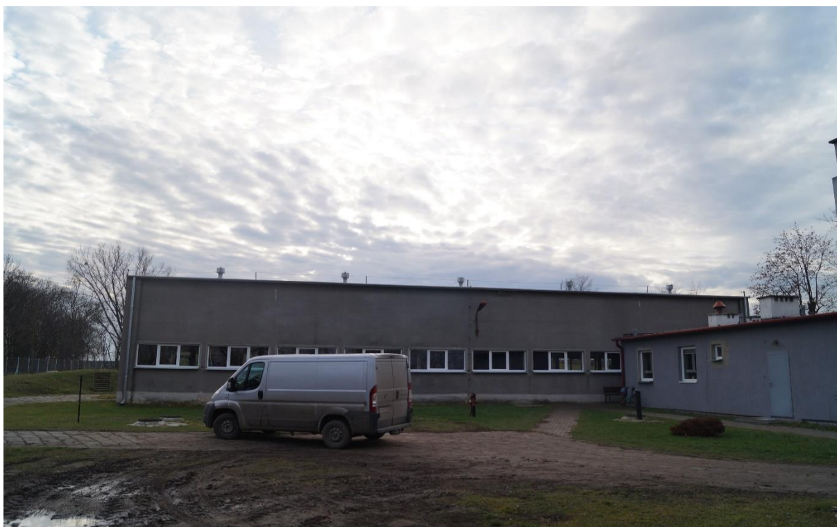
Rys. 28 SUW Dębice budynek
