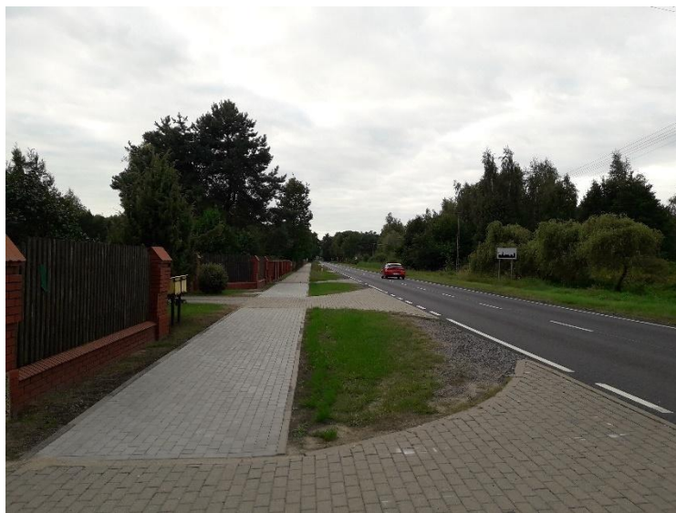
Fot. Droga krajowa nr 19 w miejscowości Skoki Duże
