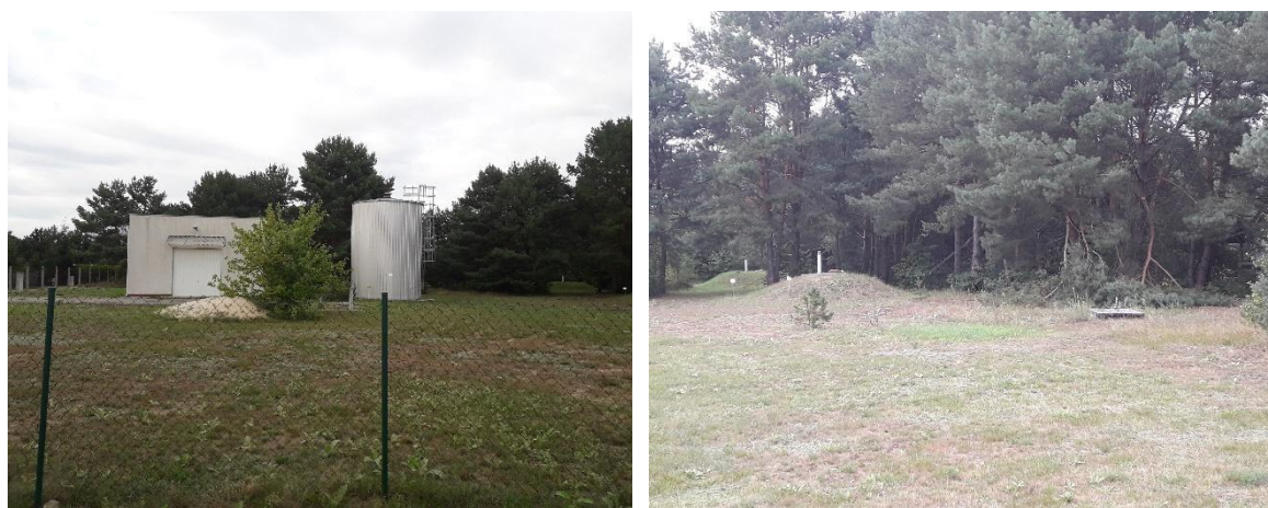
Fot. Dąb Polski – ujęcie wody ze stacją uzdatniania wody
