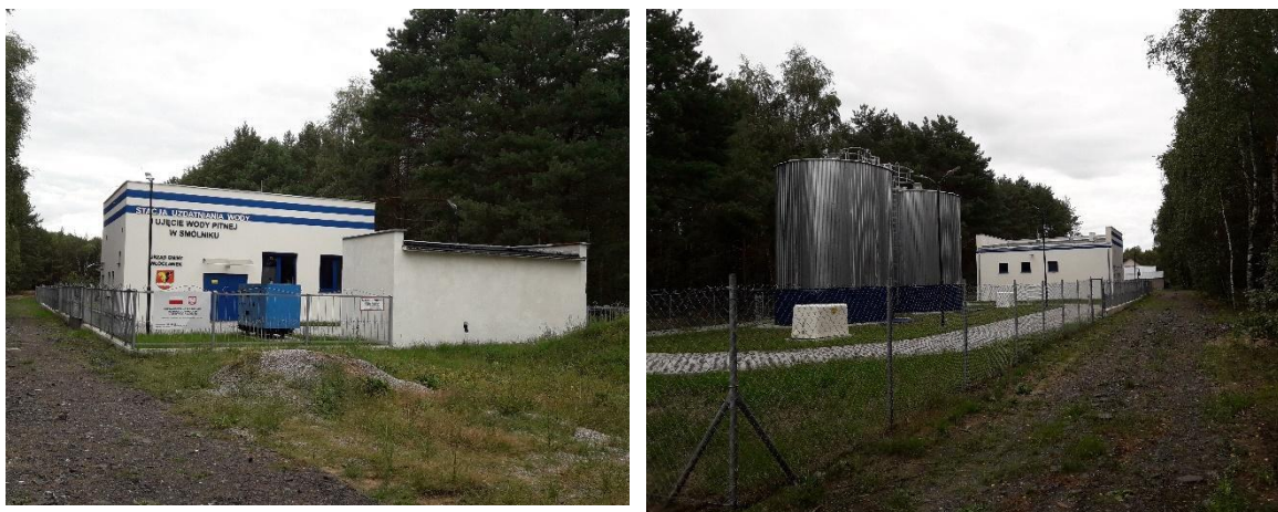
Fot. Smólnik – ujęcie wody ze stacją uzdatniania wody
