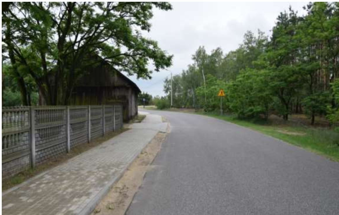
/Zdjęcie własne: budowa chodnika w miejscowości Warząchewka Królewska/
