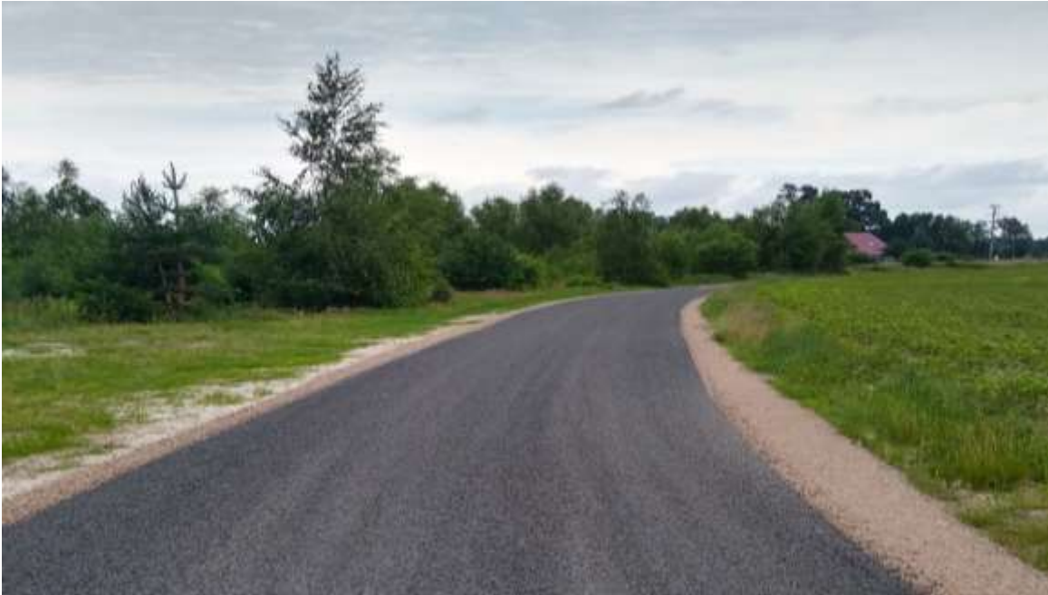
/Zdjęcie własne: przebudowana droga w miejscowości Józefowo/
