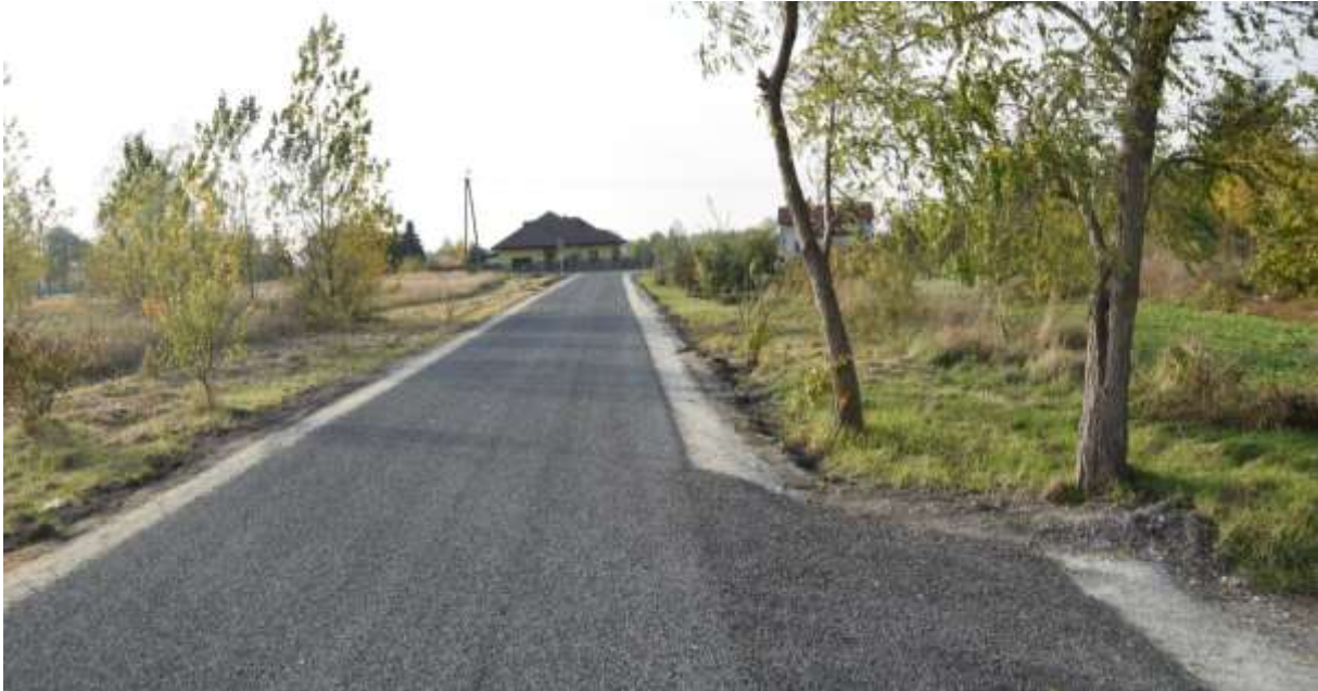
/Zdjęcie Własne: droga w miejscowości Kruszynek/
