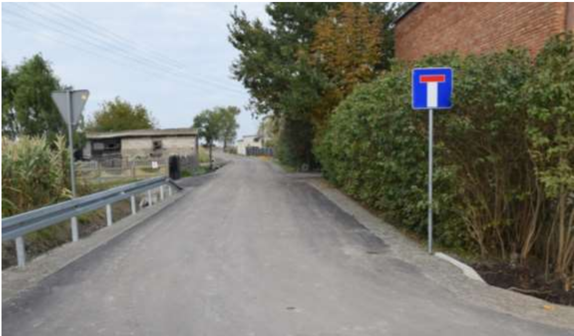
/Zdjęcie własne: przebudowana droga w miejscowości Gróbce
