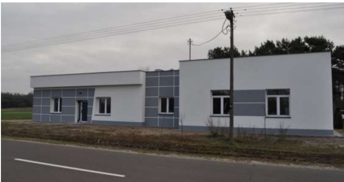
/Zdjęcie własne: termomodernizacja świetlicy wiejskiej w miejscowości Telążna Leśna/
