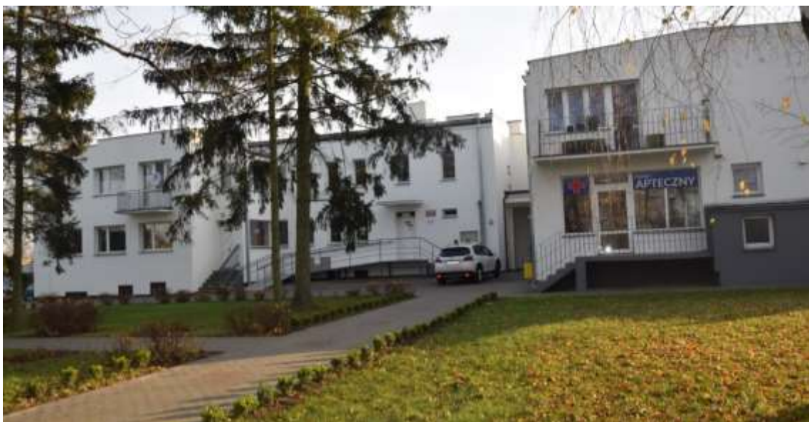
/Zdjęcie własne: zmodernizowany budynek Samodzielnego Publicznego Zakładu Opieki Zdrowotnej w Kruszynie/
