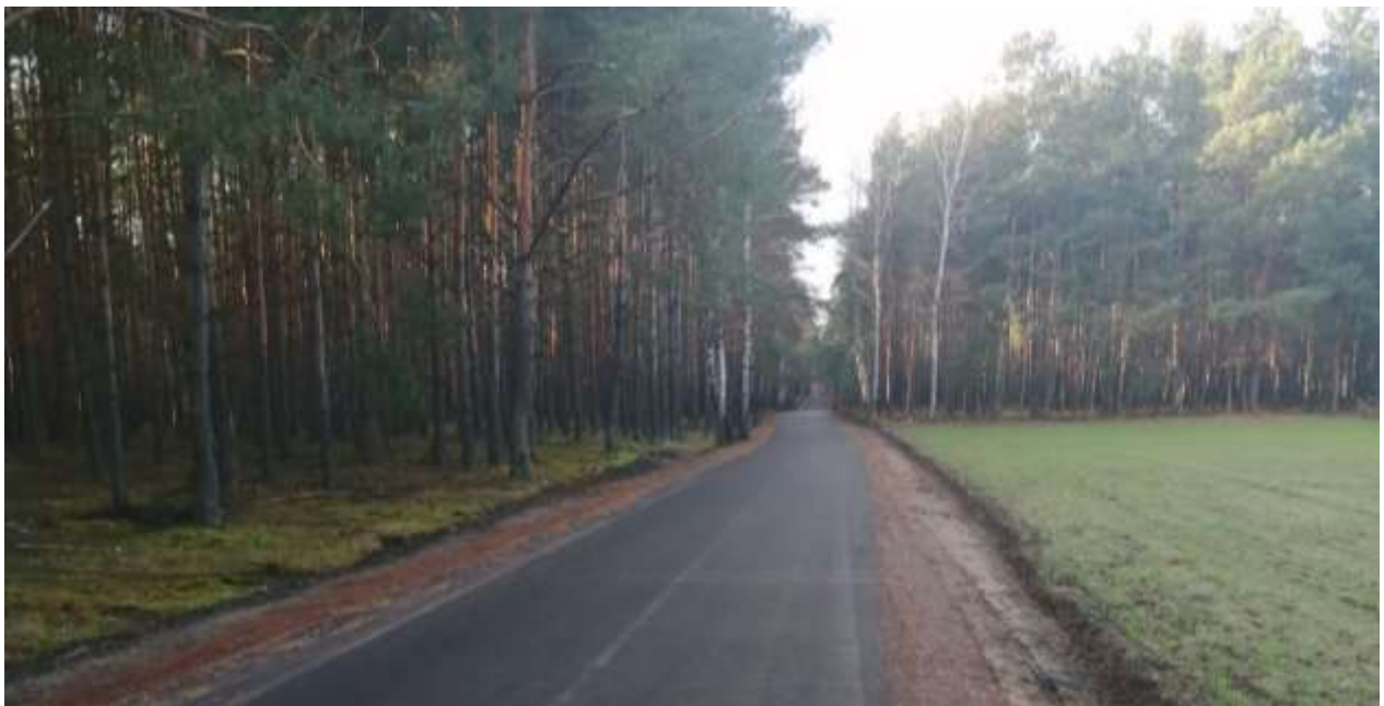
/Zdjęcie własne: droga gminna Zuzółka – Kosinowo/
