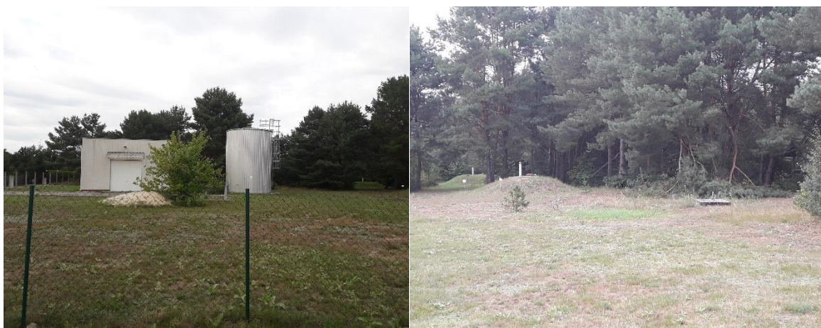
Fot. 21. Dąb Polski – ujęcie wody ze stacją uzdatniania wody
