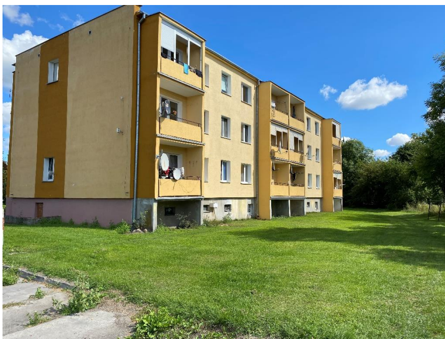
Fot. 16. Bloki mieszkalne w miejscowości Świętosław
