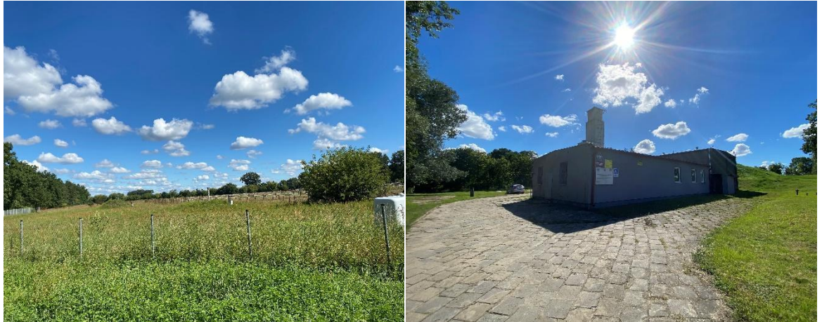
Fot. 19. Dębice – ujęcie wody ze stacją uzdatniania wody
