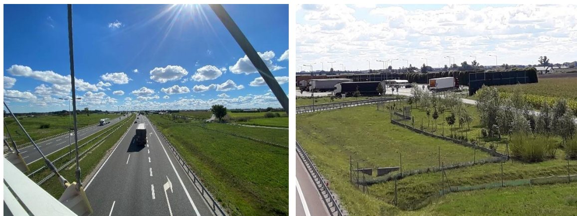
Fot. Autostrada A-1 w rejonie Ludwinowa wraz z MOP
