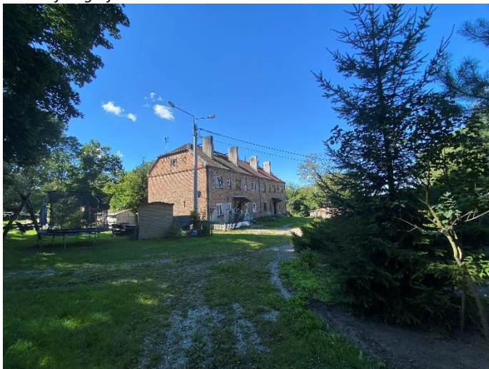
Fot. Dębice – budynek mieszkalny folwarczny czworak
