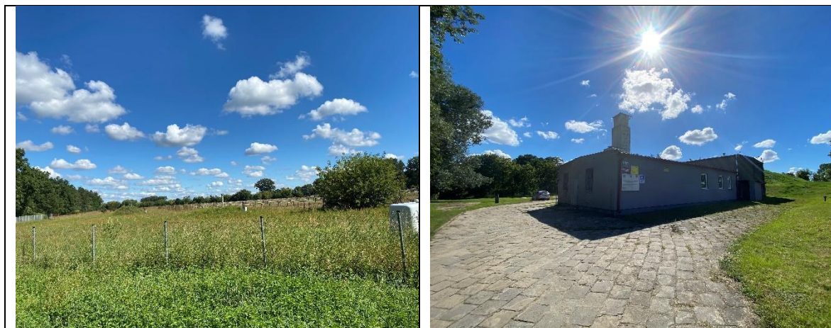
Fot. Dębice – ujęcie wody ze stacją uzdatniania wody
