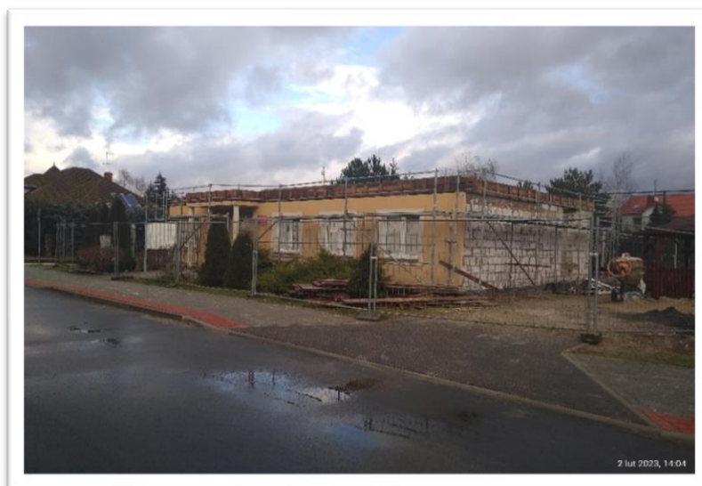
Rozbudowa świetlicy wiejskiej w miejscowości Nowa Wieś (fot. UG Włocławek)
