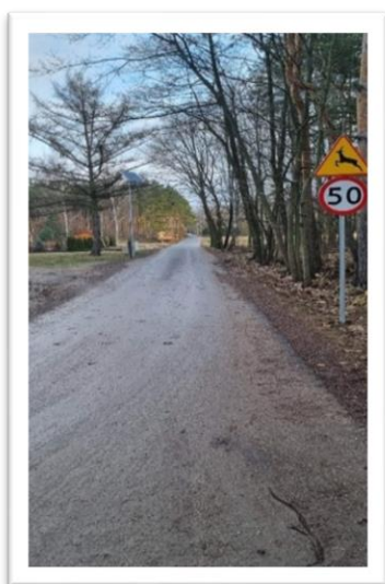
Przebudowany odcinek drogi Wistka Szlachecka – Stasin (fot. UG Włocławek)
