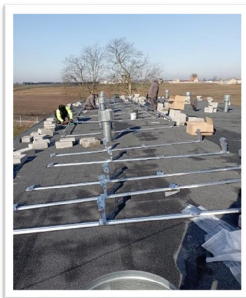
Montaż paneli fotowoltaicznych na dachu SUW Dębice (fot. UG Włocławek)
