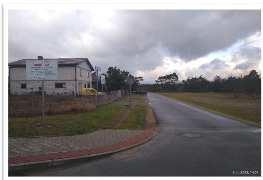
Przebudowana ulica Rubinowa w miejscowości Nowa Wieś (fot. UG Włocławek)
