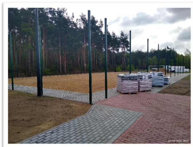
Budowa boiska sportowego w miejscowości Józefowo (fot. UG Włocławek)
