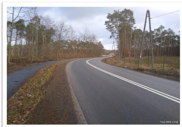
Przebudowa drogi gminnej w miejscowości Pińczata (fot. UG Włocławek)
