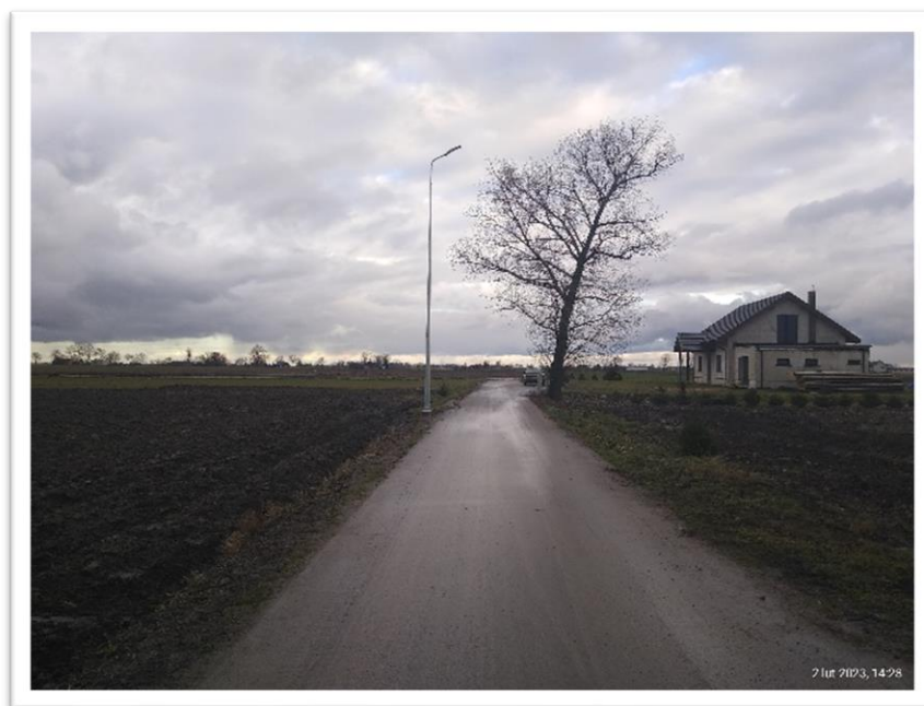
Oświetlenie drogowe w miejscowości Gróbce (fot. UG Włocławek)
