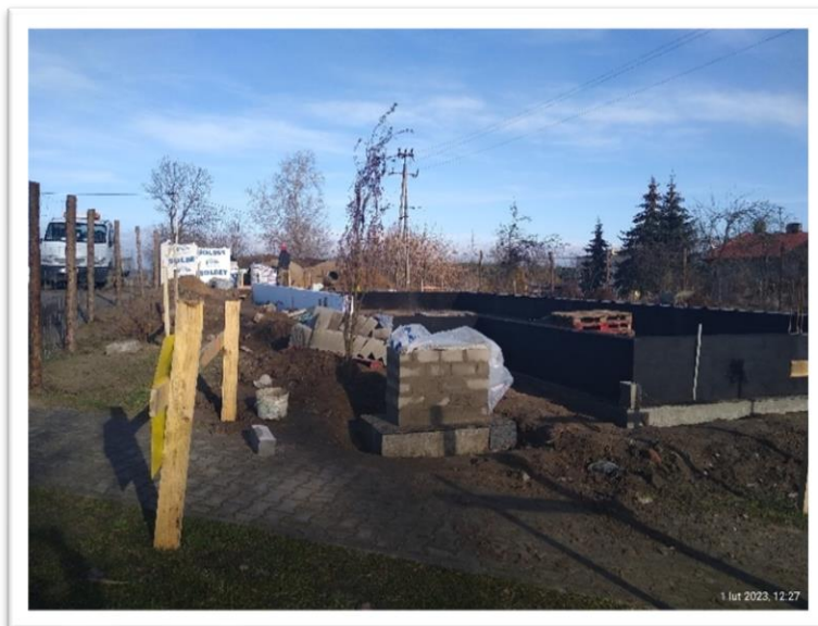
Budowa świetlicy wiejskiej w miejscowości Dębice (fot. UG Włocławek)
