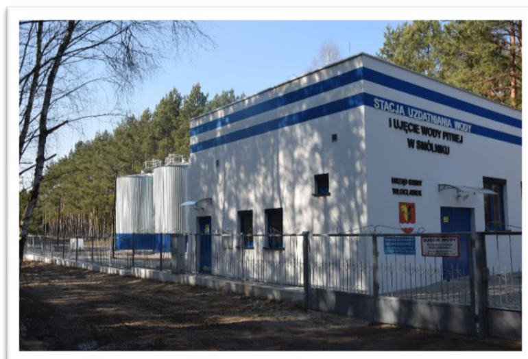
Stacja Uzdatniania Wody w Smólniku (fot. UG Włocławek)
