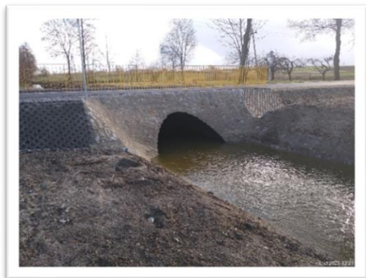
Przebudowany przepust drogowy i odcinek drogi gminnej w miejscowości Łagiewniki (fot. UG Włocławek)
