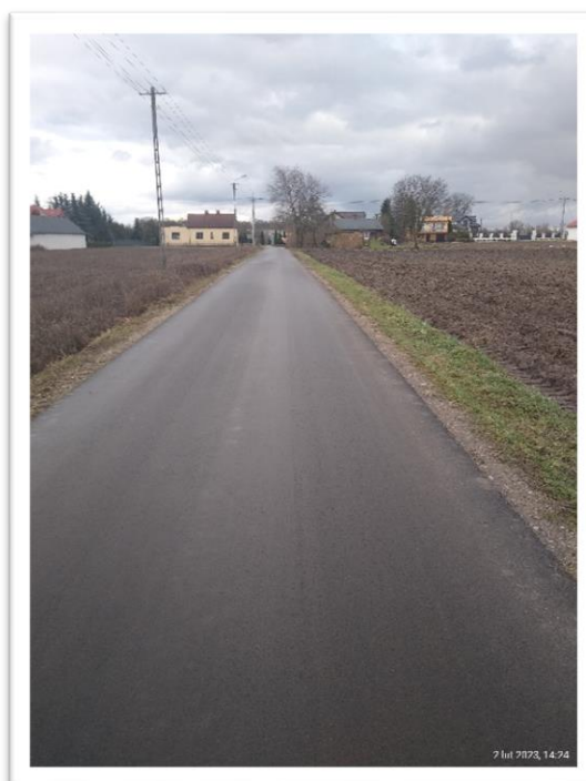
Przebudowana droga gminna w miejscowości Kruszynek (fot. UG Włocławek)
