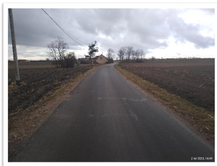
Przebudowany odcinek drogi gminnej w miejscowości Markowo (fot. UG Włocławek)
