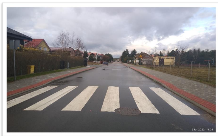
Przebudowana ulica Szafirowa w miejscowości Nowa Wieś (fot. UG Włocławek)
