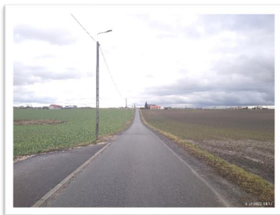
Oświetlenie drogowe w miejscowości Kruszynek (fot. UG Włocławek)
